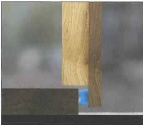
Abb. 4.14 Türschwellen mit Dichtungsprofilen, auch für den nachträglichen Einbau.
